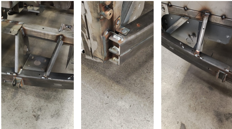
Gambar 4. Hasil material yang sudah di las
