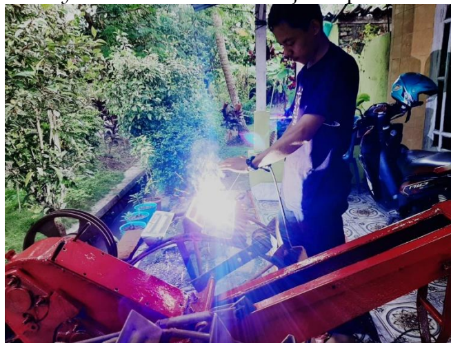
Gambar 6. Proses Pengelasan Body dan Chasis Traktor
