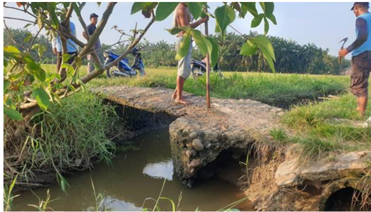
Gambar 1. Kondisi Jembatan Jalan Usaha Tani
