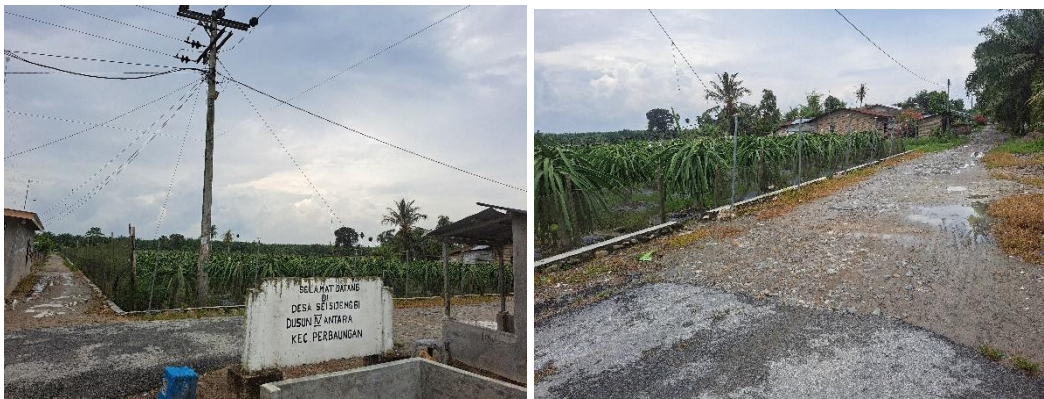
Gambar 2. Kondisi akses jalan
